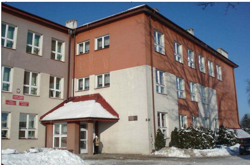
il.9. Krasnosielc, budynek szkoły, fot. T. Bielawski 2010r.
