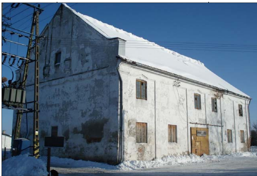
il.3. Krasnosielc, budynek byłej synagogi, fot. T. Bielawski 2010r.
