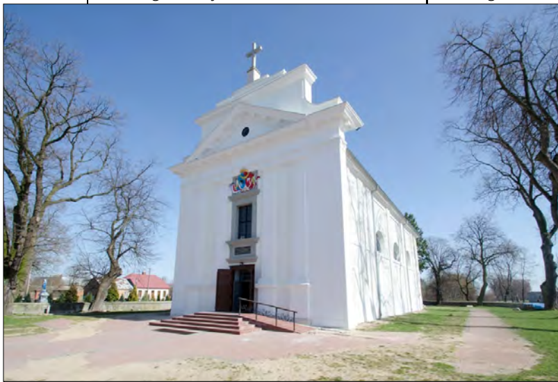
Kościół w Krasnosielcu, zbudowany w latach 1790–1792. Źródło: http://gminakrasnosielc.pl/turystyka/zabytki/kosciol-parafialny-pw-sw-jana-kantego-w-krasnosielcu/ (dostęp 27 XI 2018 r.).
