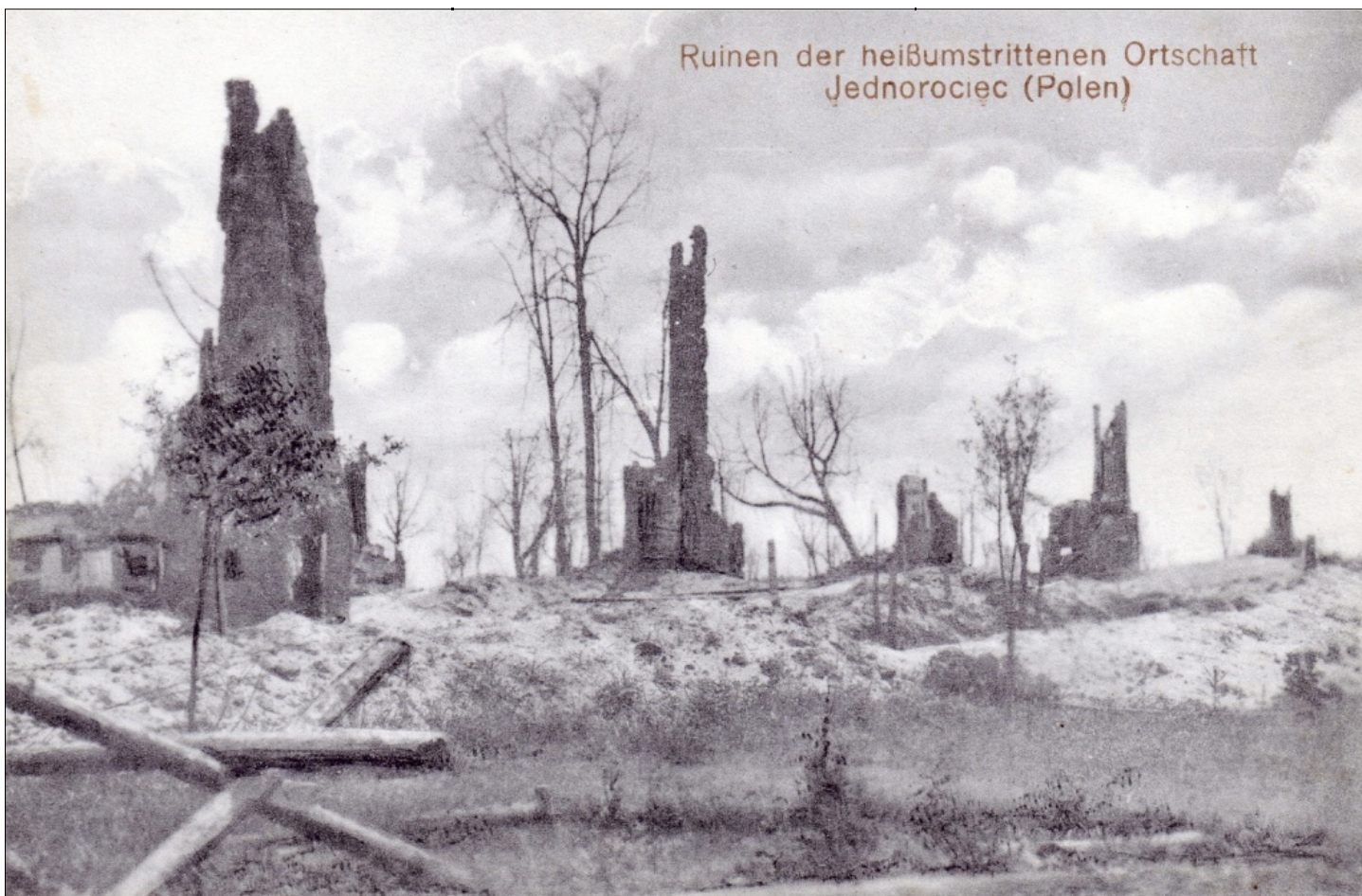
Jednorzec po zniszczeniach w 1915 r. Zbiory Mirosława Krejpowicza.
