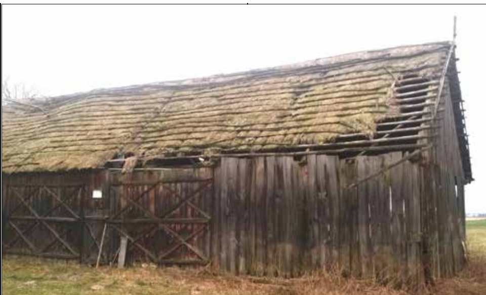
Drewniana stodoła kryta strzechą, znajdująca się w Chłopiej Łące. Fot. D.W. Budny.
