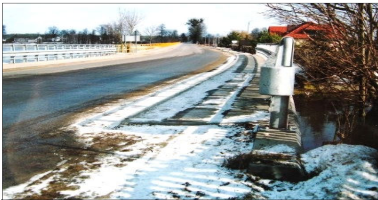
il. 8. Drażdzewo, most na Orzycu z charakterystycznym wygięciem łukowym w miejscu posadowienia pierwotnego młyna. Przejazd mostowy omijał budynek młyna, stąd wzięło się wygięcie łukowe, fot. C. Kocot 2009.
