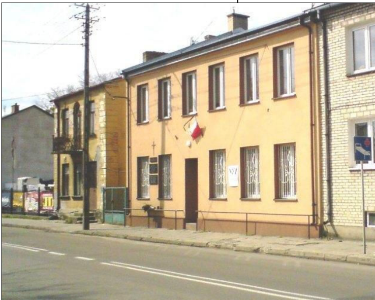
2. Krasnosielec, budynek byłej siedziby Powiatowego Urzędu Bezpieczeństwa Publicznego (1945); obecnie ośrodek zdrowia. Fot. M. Chodkowski.
