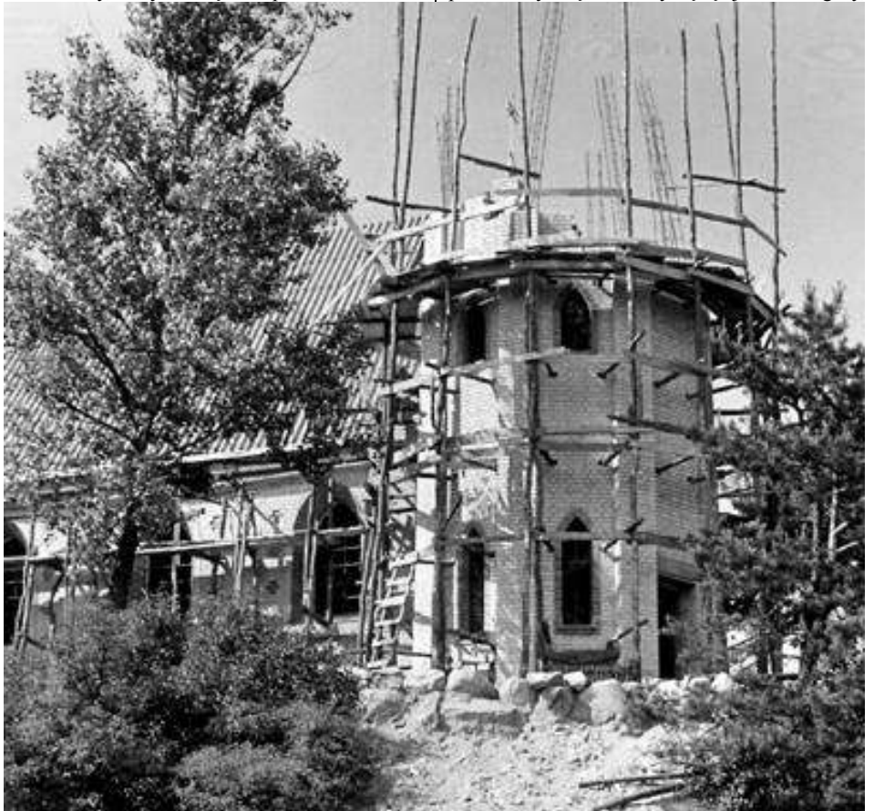
Budowa wieży kościelnej na Górze Krzyżewskiej. Wieża opiera się na solidnych fundamentach wkopanych w ziemię na 3,5 metra w głąb. Miała być trochę wyższa, ale ksiądz się nie zgodził.
