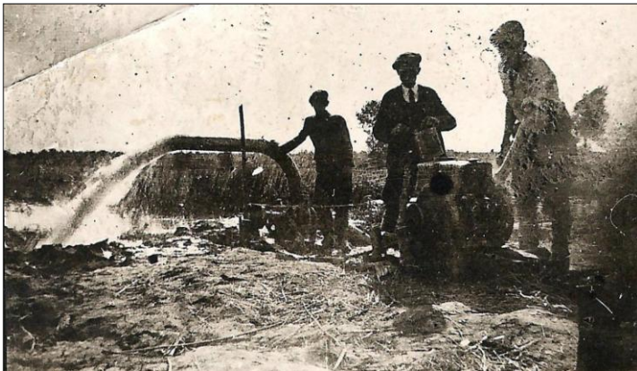
Prace przy regulacji Orzycu. Zbiory Muzeum Historycznego w Przasnyszu.
