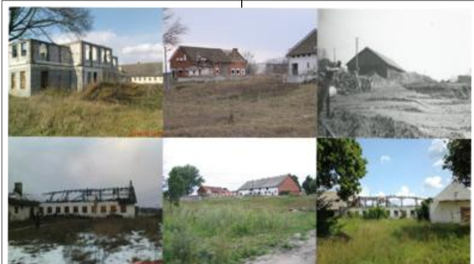
Pozostałości po budynkach gospodarstwa szkolnego – stan z roku 2013.
