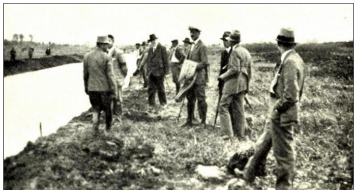
Kontrola postępu prac – można przejść suchą nogą w miejscu, gdzie dawniej wodą sięgała kolan. Źródło: W. Szczypiorski, Rzeka Orzyc... , s. 22.
