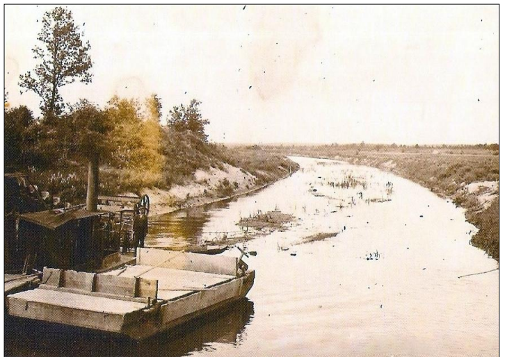
Pogłębiarka parowa na Orzycu ok. 1934–1935 r. Zbiory Muzeum Historycznego w Przasnyszu.
