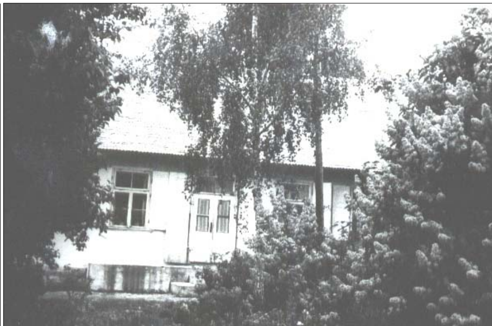
Plebania drewniana (widok od strony sadu).
