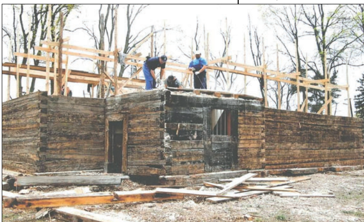
Demontaż zabytkowego kościoła – widok z boku od strony południowej.
