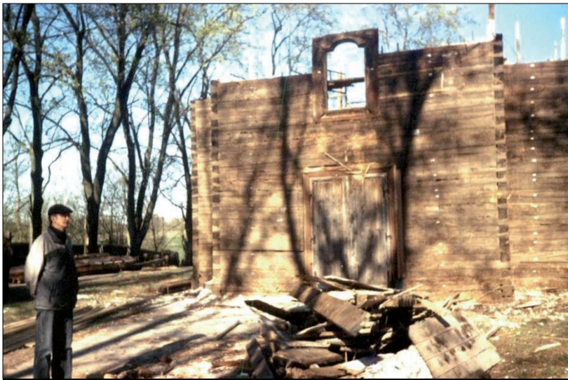
Demontaż zabytkowego kościoła – widok od strony głównego wejścia, kwiecień
