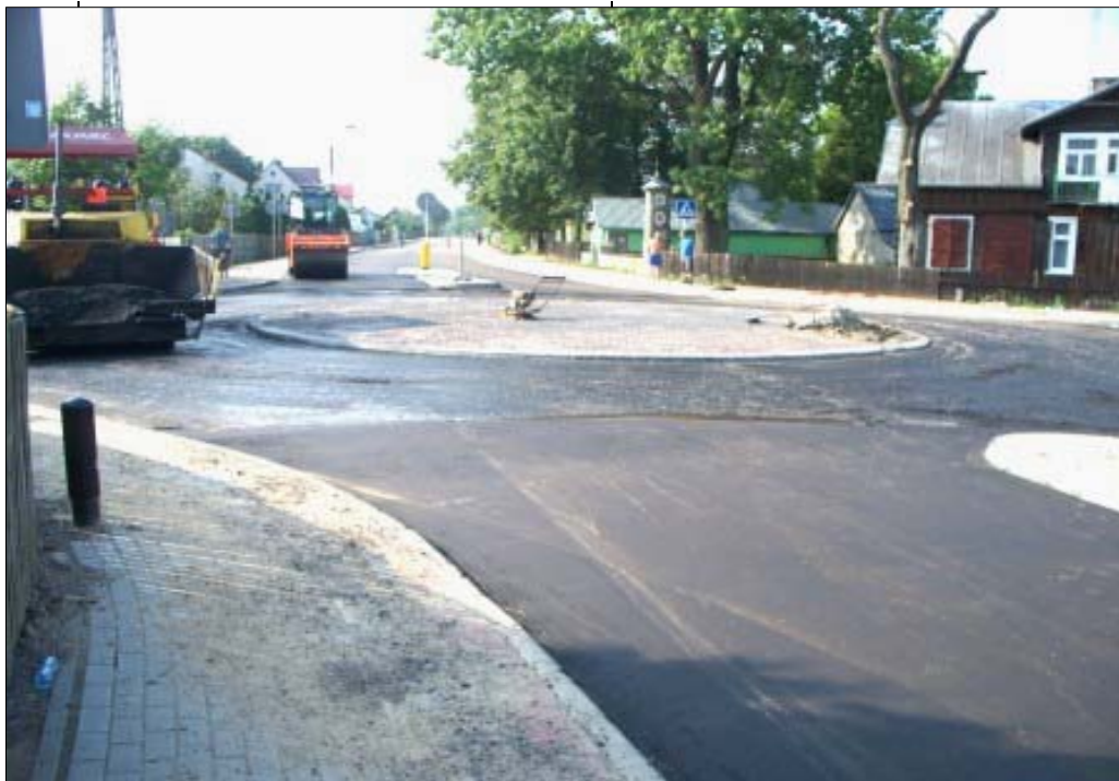
Budowa ronda, fot. 2010 r.
