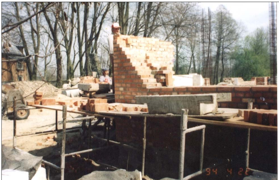
Budowa kościoła, w tle kościół drewniany i kamienny pomnik, fot. 1994 r.
