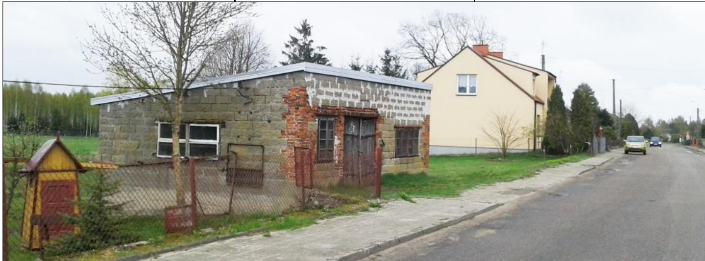
Budynek byłej kuźni w Drążdzewie u państwa Pogorzelskich. Foto. z dnia 27 kwietnia 2016 r. Sławomir Rutkowski.
