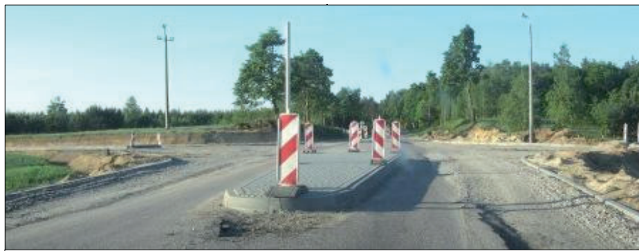
Budowane na tzw. „Tysiąclatce” rondo w m. Nowy Podoś.
