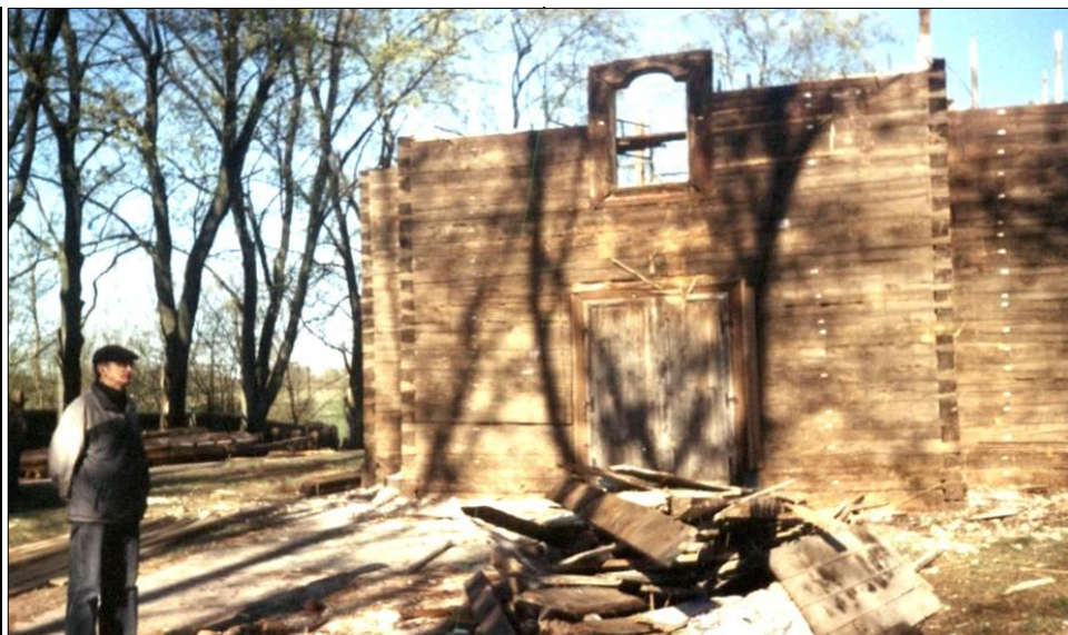
Demontaż zabytkowego kościoła – widok od strony głównego wejścia, kwiecień 2007 r.
