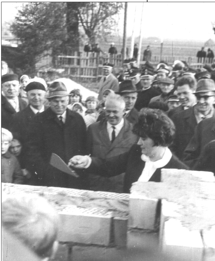
Posłanka Kamila Kurowska wmurowuje akt erekcyjny pod budowę szkoły w Dąrdżewie, 24.11.1968
