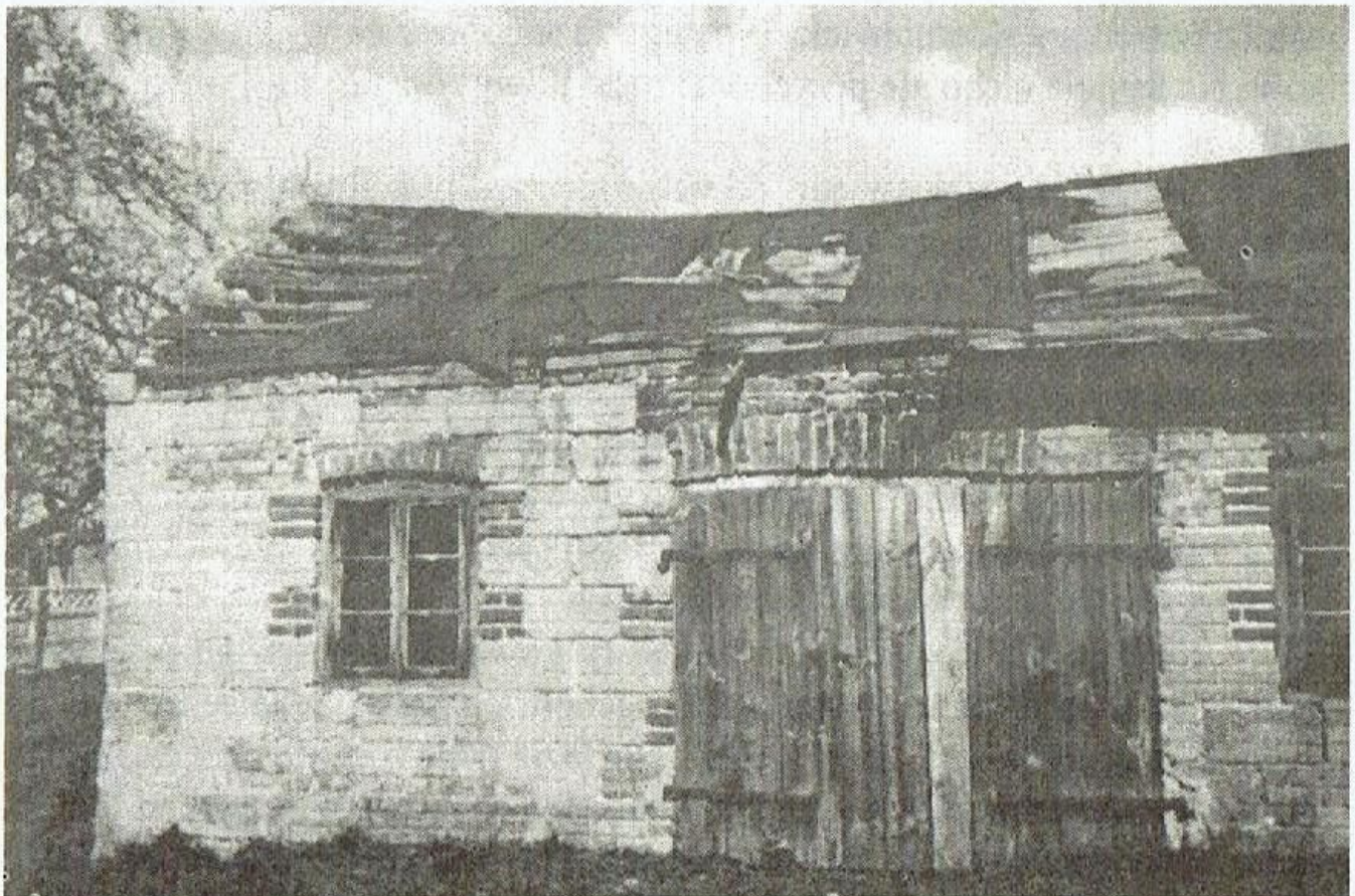
Budynek olejarni Szczepana Maciejaka w Woli Makowskiej. Wszystkie urządzenia mieściły się wewnątrz budynku a praca odbywała się nocą.
