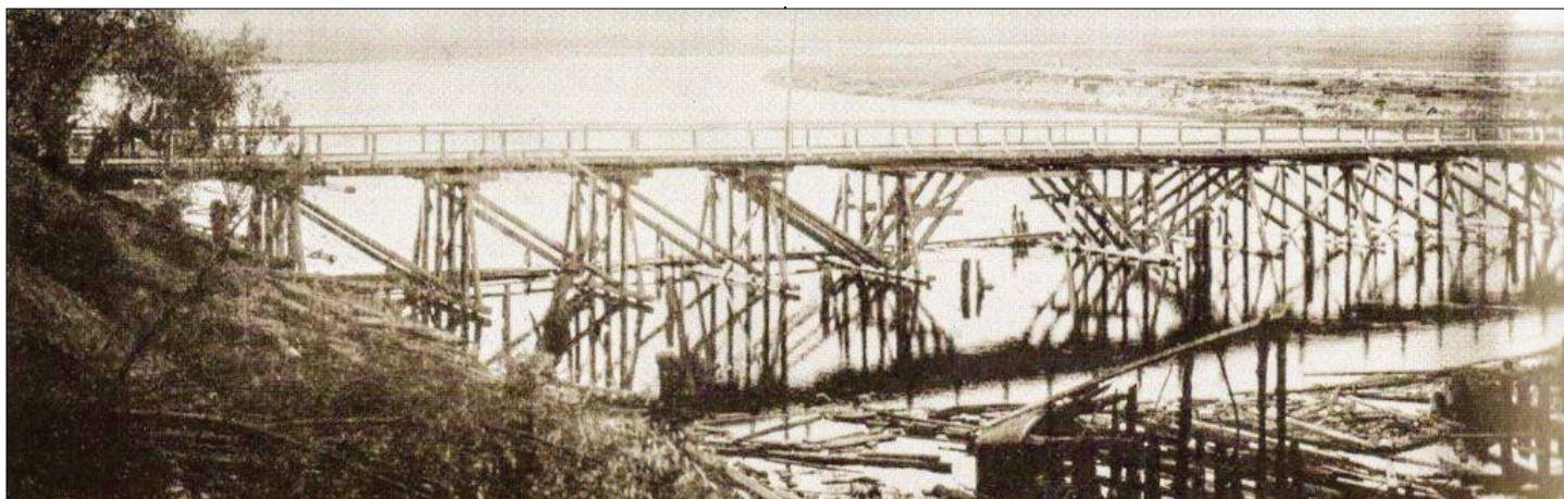
Ryc. 5. Zniszczony przez armię rosyjską most na Narwi w Róźnie. Na drugim planie widoczne prace przy budowie nowej przeprawy. Nowy most zaczęto budować od strony Kaszewca, by transportować drzewo z pobliskich lasów. Zaplanowano kratownicę tak, by pod mostem, środkiem nurtu, mogły przepływać barki i łodzie. Zbiory Muzeum Ziemi Makowskiej i Garnizonu Różan. Źródło: R.Ch. Gallera, W. Łaskarzewski, J. Furmańczyk, Kalendarium wydarzeń Wielkiej Wojny 1914–1915 na Mazowszu Północnym ze szczególnym uwzględnieniem powiatu makowskiego , Maków Mazowiecki 2021, s. 194.
